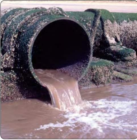
شكل (١١٧) أحدى قنوات الصرف الصحي
