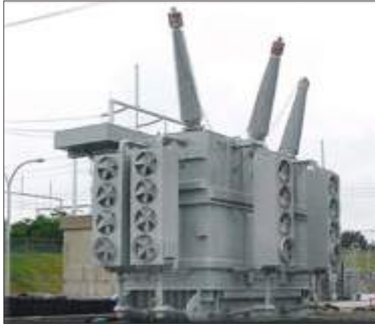
(b) محولة رافعة في محطات تجهيز الطاقة الكهربائية الى المدن.
