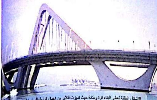
الانكسار المثلثية تحسلي البناء قوة وممتدة حيث تمزت الكثير من اعمال الرحلة الهندسة العراقية في جوهريه الانكسار الهندسية المثلثية، ومنها جسر في ابو ظبي بلغ ارتفاع راس المثلث 60m فوق مستوى سطح البحر
